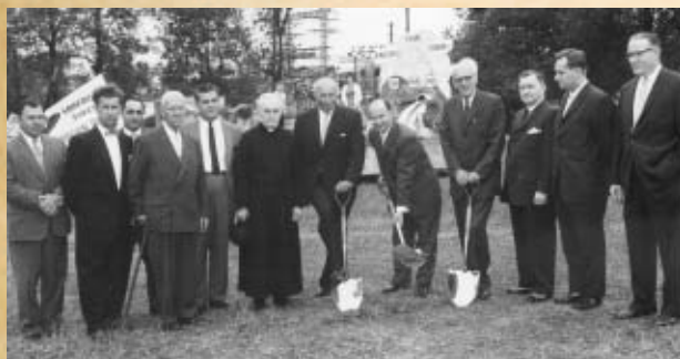
Levée d'une pelletée de terre de la future usine d'alimentation en eau, en 1959. On peut voir Edmond Auclair au centre tenant une pelle d'une main (Collection SHBMSH)
